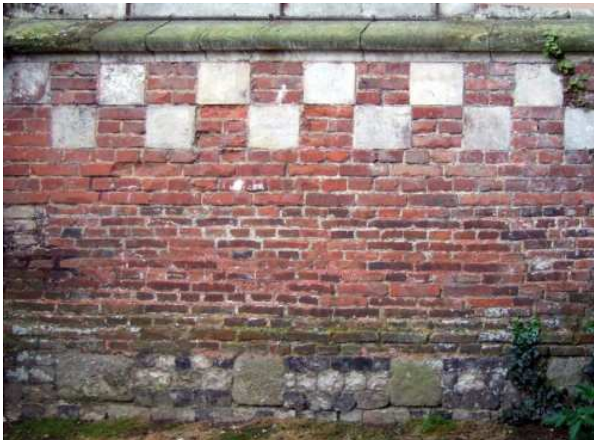
Détail de la façade extérieure de la nef
