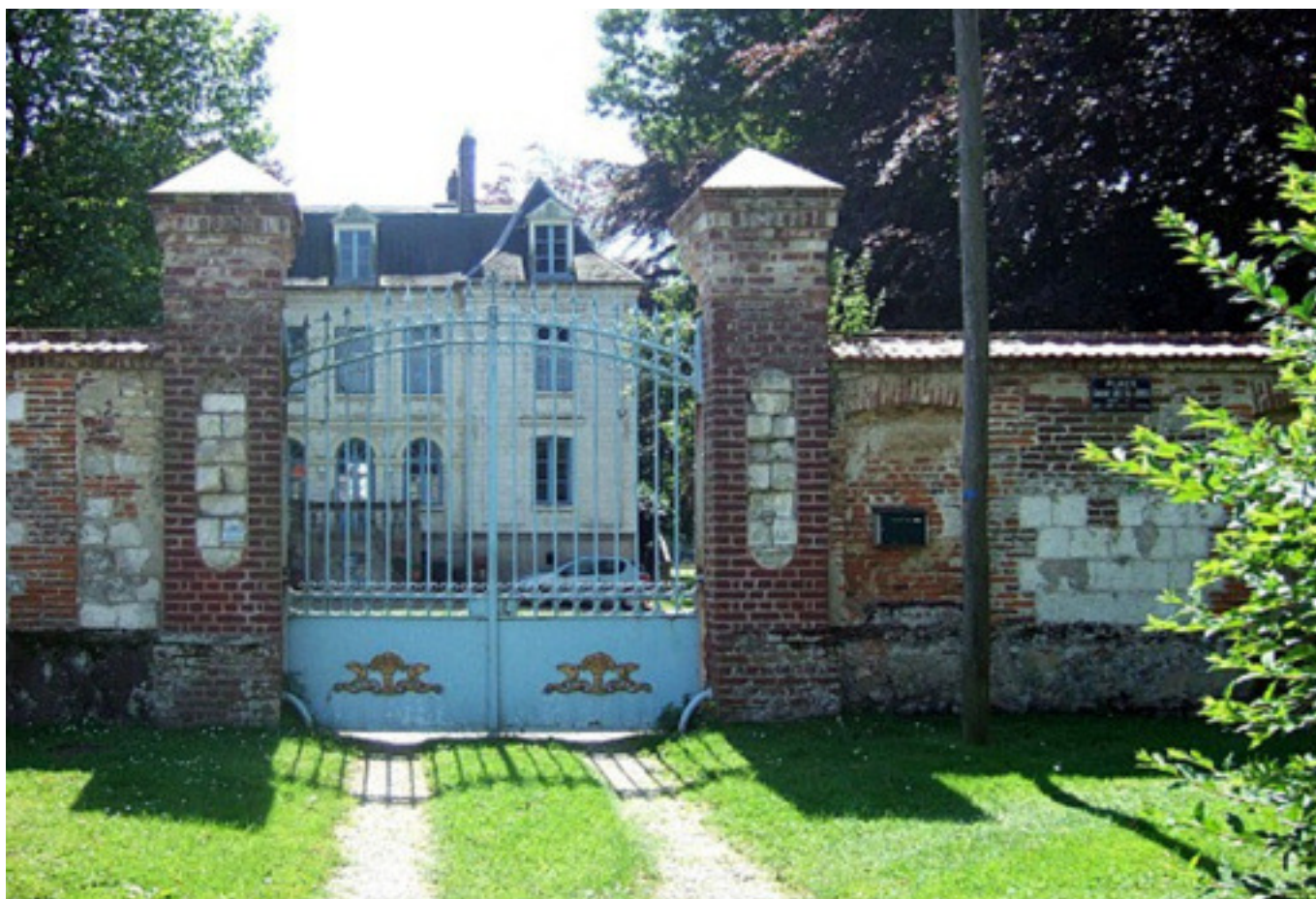
Le mur d'enceinte et le portail
